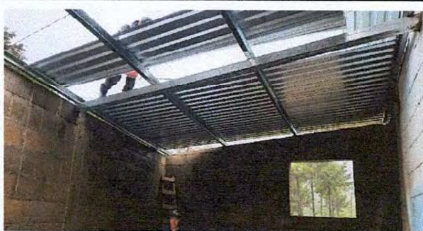
Foto1: Colocación lámina troquelada Aluzinc calibre 26.
