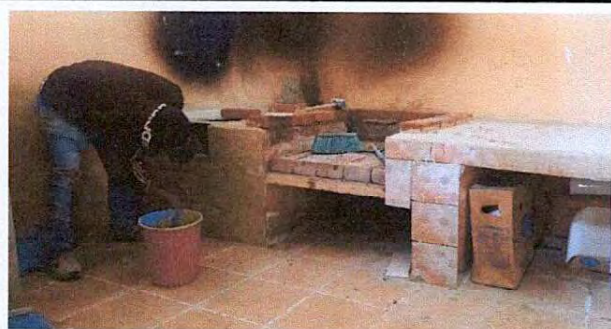
Foto 15: Sustitución de Estufa Rural, colocación de Azulejos y Chimenea.
