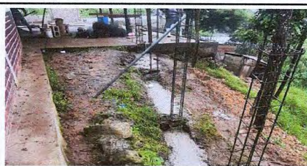
Foto 12: Colocación y Reforzamiento de muro de contención 20mts. Lineal.
