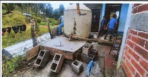
Foto 13: Sustitución de depósito de Agua Tinaco, accesorios y base de concreto.
