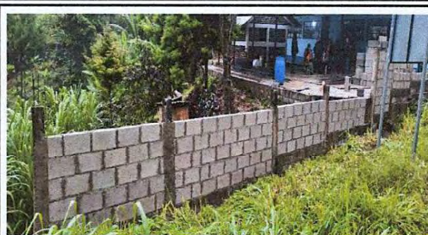
Foto 8: Lateral: Sustitución de Malla Galvanizada por Muro perimetral de Block más repello exterior.
