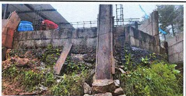
Foto 11: Reforzamiento de columna de muro de contención.
