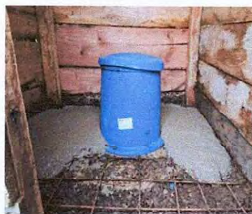
Foto 18: Colocación de torta de cemento, sustitución de letrina de cemento a plástico.
