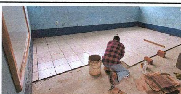
Foto 6: Sustitución de piso de cemento por cerámico. Modulo de Sexto Primaria. 6.75x5.75
