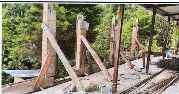
Foto 17: Sustitución de Tubo Galvanizada por columnas y Malla Galvanizada. 18 mts. Lineal.
