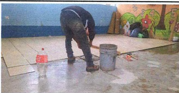
Foto 5: Sustitución de piso de cemento por cerámico. Modulo de Primero Primaria. 6.75x5.75
