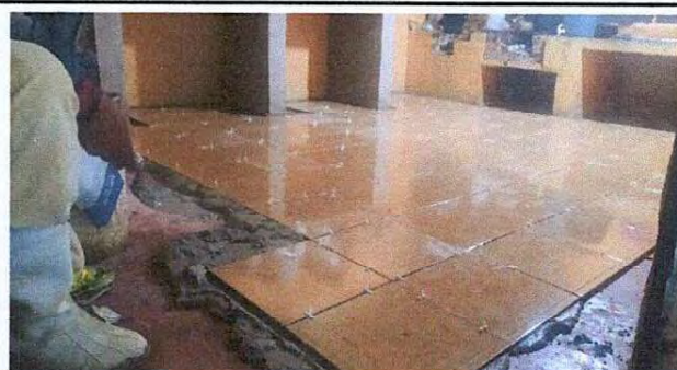
Foto 16: Colocación de piso liso a piso cerámico.
