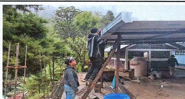
Foto 14: Sustitución de Tubo Pvc 3" a Canal de Metal. 10mts. Largo.
