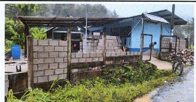
Foto 9: Frontal: Sustitución de Malla Galvanizada por Muro perimetral de Block más repello.
